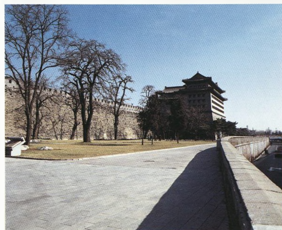
北京城东南角楼
